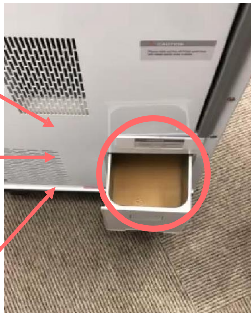
外部給水タンク
